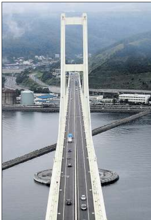
GERADE FÜR BRÜCKEN wie diese auf der Insel Hokkaido mit ihrem problematischen geologischen Umfeld sind Langlebigkeitskonzepte wichtig.
